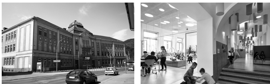
ABB 14 vor dem Umbau ©2013 Stadt Leoben / eine neue Mitte ©2016 Kurt Hörbst
