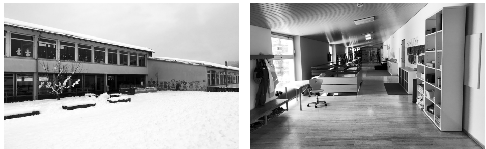
ABB 03 zweigeschoßiges, versetztes Bauwerk, überbreite Gänge ©2015 VS Andelsbuch
